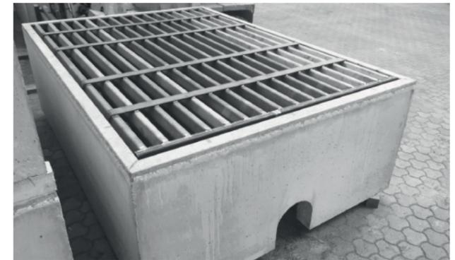
Die **einbetonierte Stahlzarge** schützt das Schachtelement und unterbindet das absplittern der Kanten zur Gänze.
